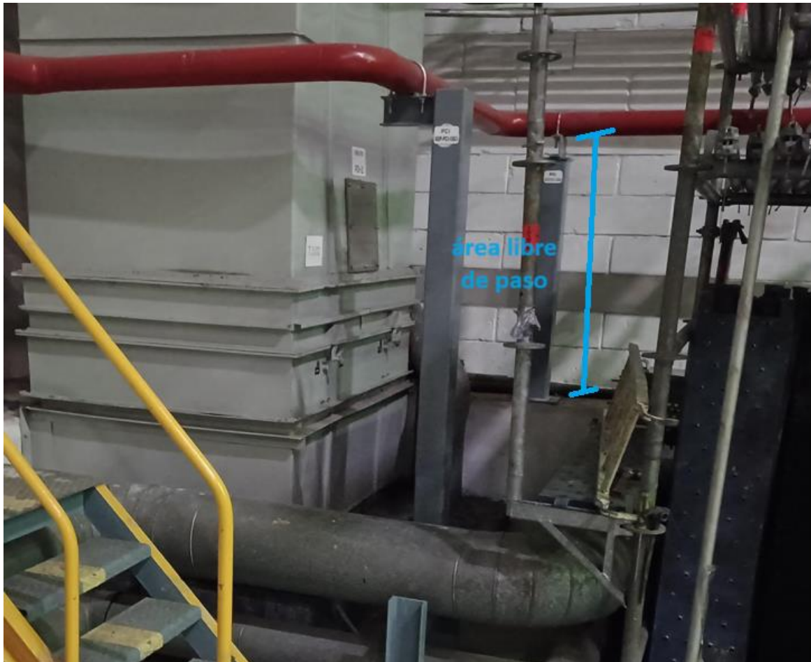
Figura 8-34: Detalle área de paso al exterior del conducto de aspiración del VTL-HVE-122B
