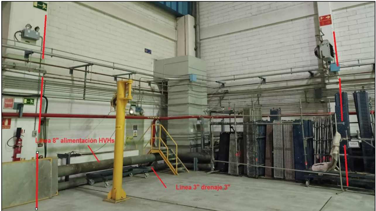
Figura 8-11: Área noreste POT, ubicación de los tramos de tuberías a retirar y escalera.
