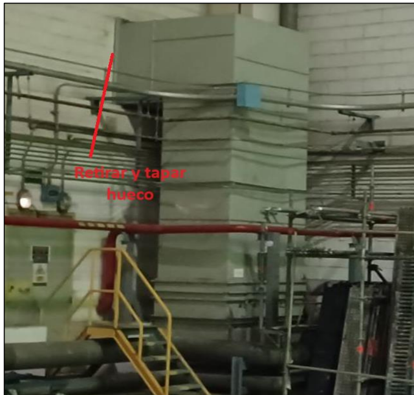
Figura 8-19: Conducto actual extracción VTL-HVE-1A/B dimensiones 1.525 x 1.1170 a retirar. Vista POT esquina noreste
