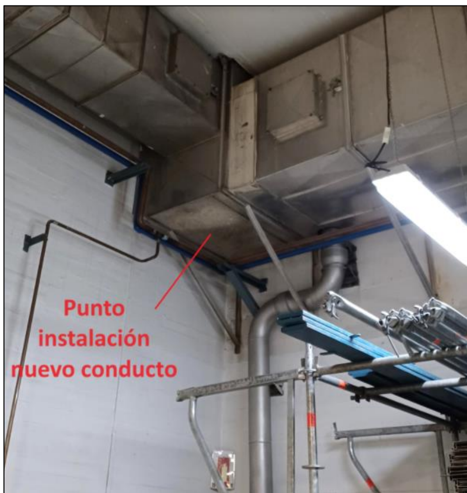
Figura 8-15: Conexión nuevo conducto en recinto T2.01.01
