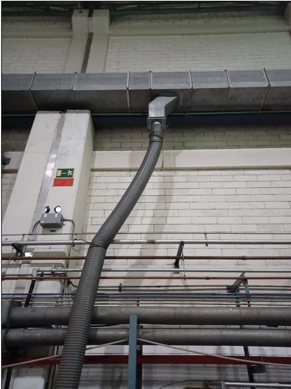
Figura 8-9: Muro norte POT, conexión tubo flexible a conducto extracción Taller Caliente
