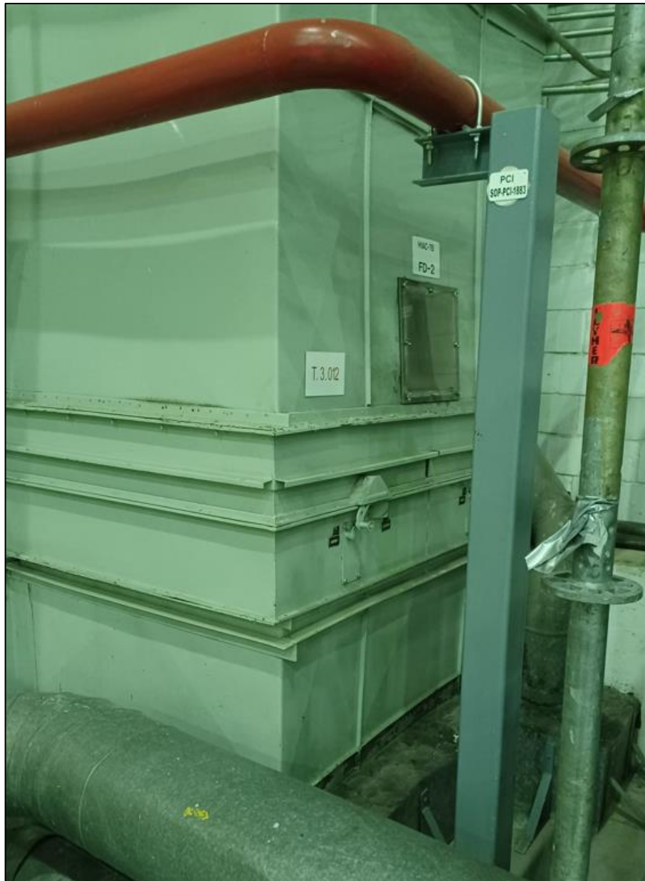
Figura 8-18: Conducto actual extracción VTL-HVE-1A/B dimensiones 1.525 x 1.1170 a retirar. Vista forjado POT
