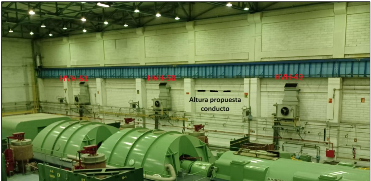
Figura 8-7: Muro sur POT identificando "fan coils" HVH-49/50/51 y altura propuesta nuevos conductos
