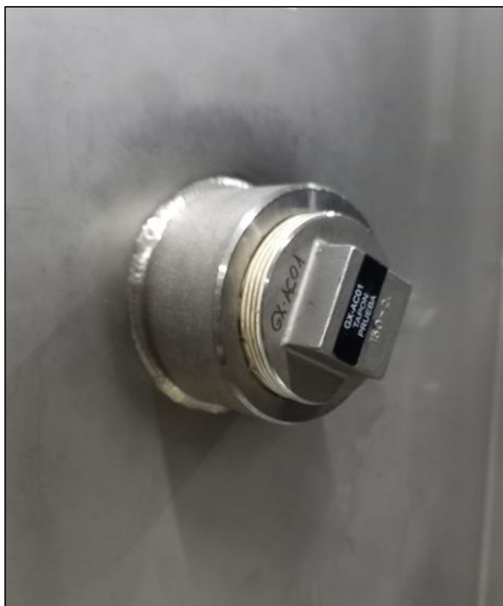
Figura 8-30: Detalle de puerto de inyección a instalar en conductos de entrada a unidades VTL-HVE-122A/B
