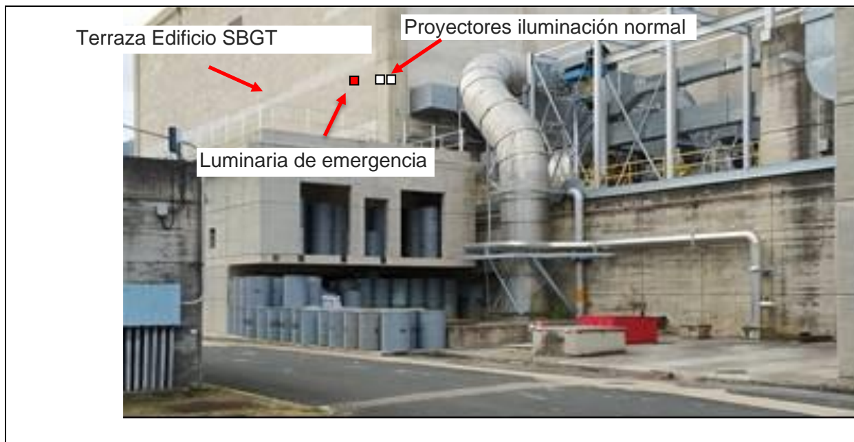
Figura 8-40: Localización propuesta de proyectores para iluminación terraza del SBTG
